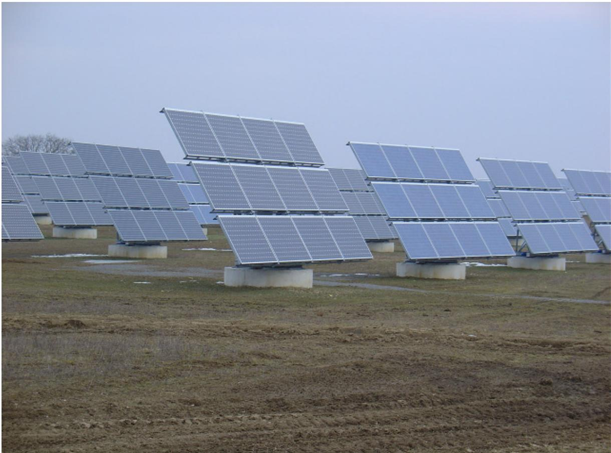
Abb. 10: Solarmover im Solarpark bei Arnstein in Unterfranken. Die Solarmover folgen durch horizontale und vertikale Beweglichkeit dem Sonnenverlauf und erzielen dadurch einen höheren Wirkungsgrad. Der Solarpark ist mit über 80 ha (noch) der größte Solarpark der Welt. (Quelle: eigenes Foto)
