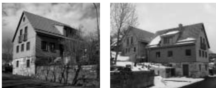
Abb. 14, 15: Ergebnisse 2002/03: Die Hofstruktur wurde erhalten, Ersatzbauten nehmen historische Vorgaben auf.
