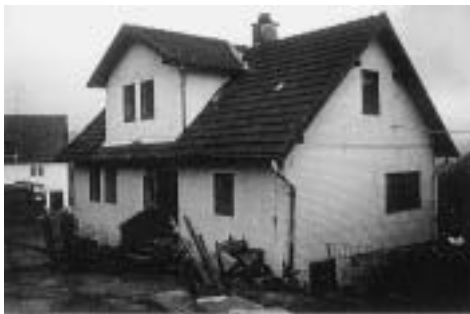
Abb. 4, oben: Typisches Rhöner Haus vor der Sanierung 1995 ...
