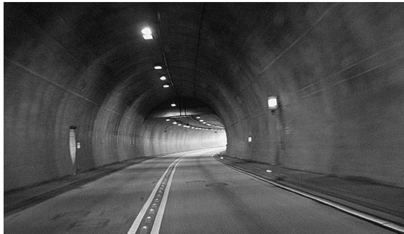
Abb. 4: RQ 10,5 T, Beispiel Tunnel B 426 (Foto: Ulrich Boeschen).
